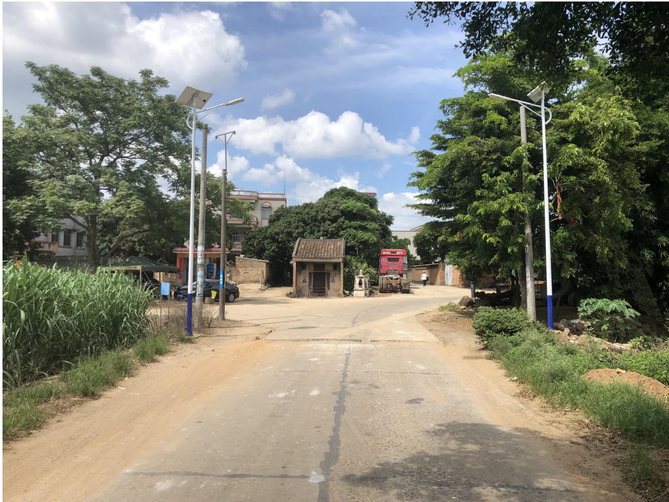
村道路改造前照片
