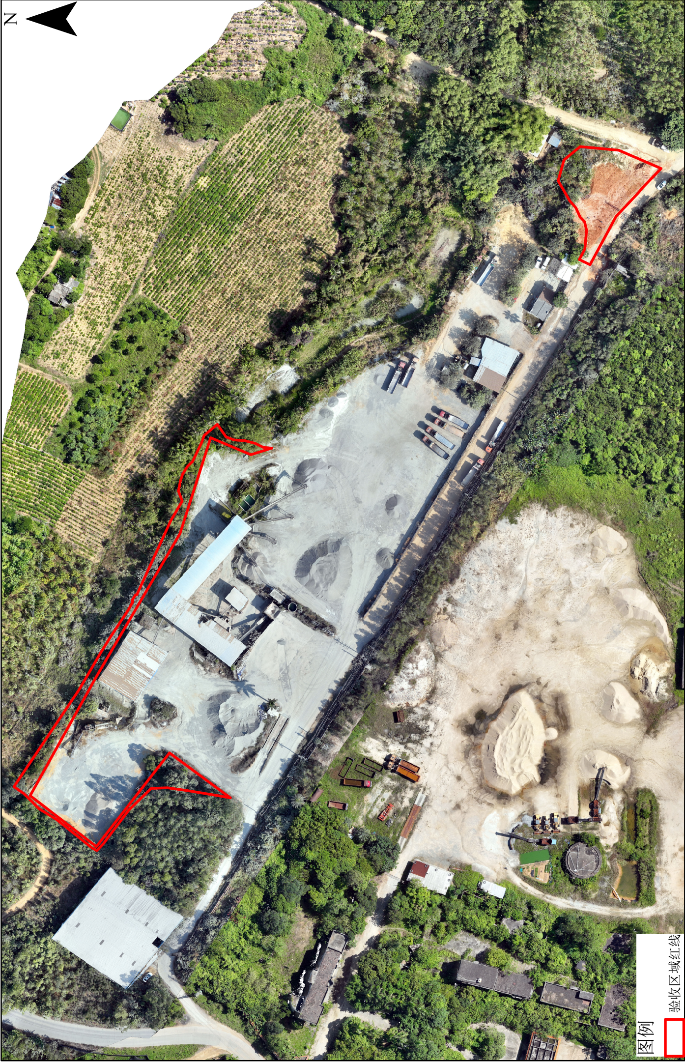
沈海国家高速公路茂名至湛江段改扩建工程项目TJ6标预制场临时用地土地复垦工程验收正射影像图
