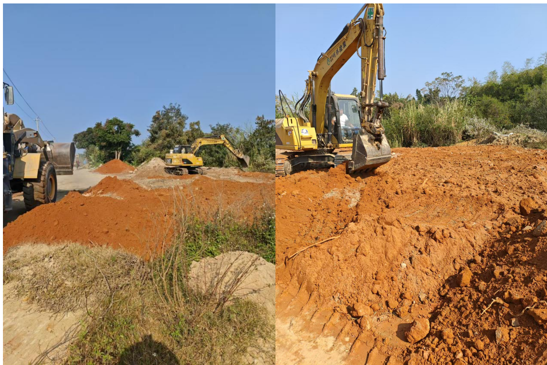
图 4-1 客土回填、土地平整
